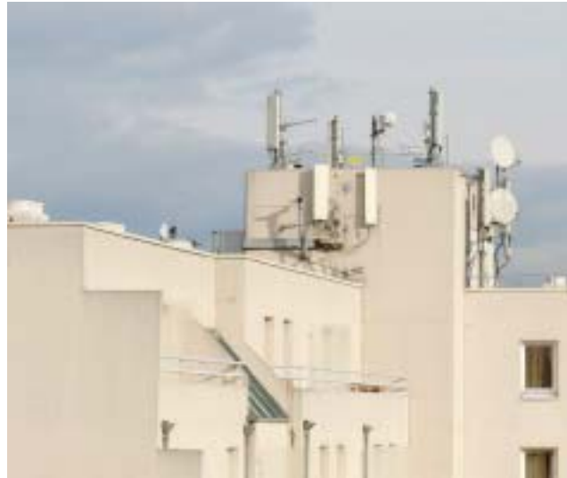
L'appartement d'Hélène est situé en face de cette "colonie" d'antennes de téléphonie mobile.
